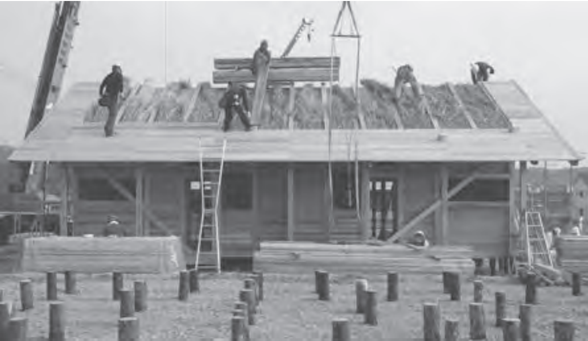
▼スギ厚板の間に茅を断熱材として入れる(福島県いわき市)
