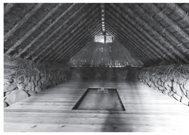
▲完成した窖「縄文窠」の内部 大きな囲炉裏もある
