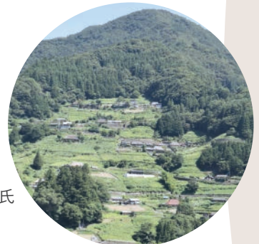
重要伝統的建造物群保存地区 「三好市東祖谷山村落合」
